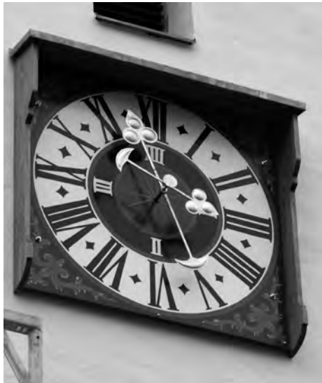
Abbildung 13: Das neue südseitige Zifferblatt erhielt nach dem Vorbild des nordseitigen ein neues Zeigerpaar, beide Zeigerpaare wurden neu vergoldet. Sie haben die aus dem Barock stammende umgekehrte Zeigerstellung mit langem Stunden- und kurzem Minutenzeiger. (Foto: Neureiter)
