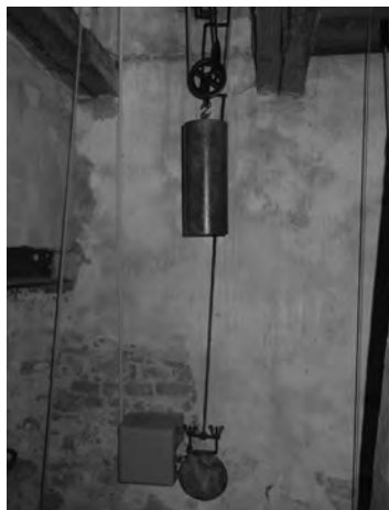
Abbildung 15: Das gemeinsame Gewicht für Gehwerk und Schlagwerk und das Pendel mit dem neuen „Pendelfänger“. Die bisherigen Gewichte waren sägeraue quadratische Bretterkisten aus der Mitte des 20. Jahrhunderts. (Foto: Neureiter)
