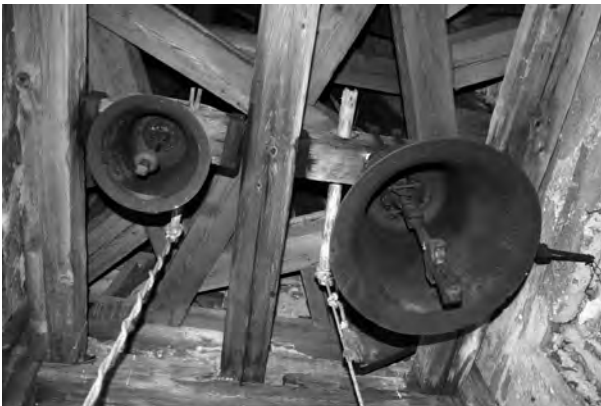
Abbildung 17: Beide Glocken im Turm der Georgskirche werden von Hand geläutet, nur die größere dient als Schlagglocke für die Turmuhr. Im Bild ist oberhalb des Glockenstuhls der neue Dachstuhl des Turmhelms zu sehen, der 2004 kurz vor dem Abschluss der Renovierung der Zellhofkirche aufgesetzt wurde. 13 (Foto: Neureiter)
