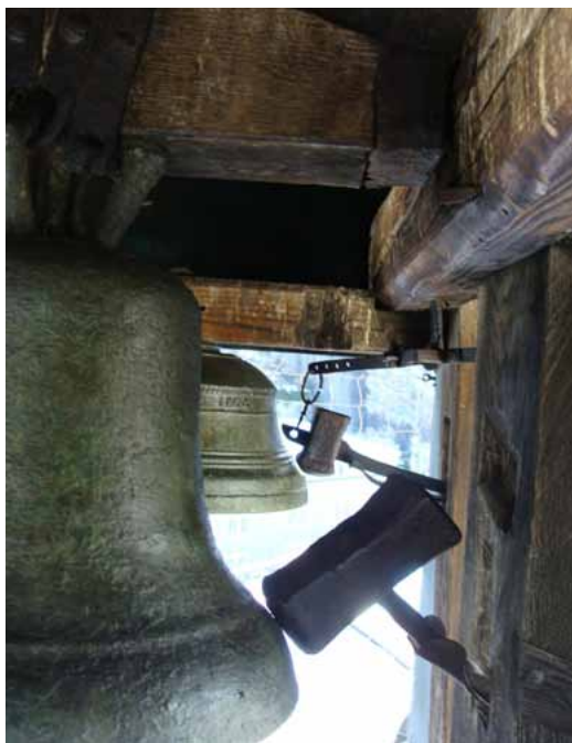
Abb. 17 Glocke und Schelle nach der Restaurierung wieder im Dachreiter – mit den ebenfalls restaurierten Schlaghämmern aus dem 18. Jahrhundert
